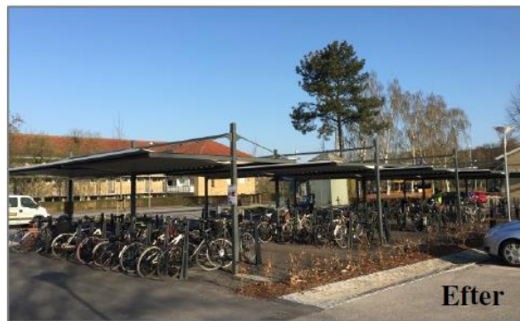
9 bilparkeringspladser blev inddraget for at få plads til tilstrækkelig overdækninger.
