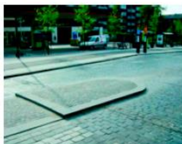
Vejbelægningen ved holdepladsen foran Hørsholm Midtpunkt er af savede brosten, der med kvalitet og udformning signalerer krydsende fodgængere og cyklister.
