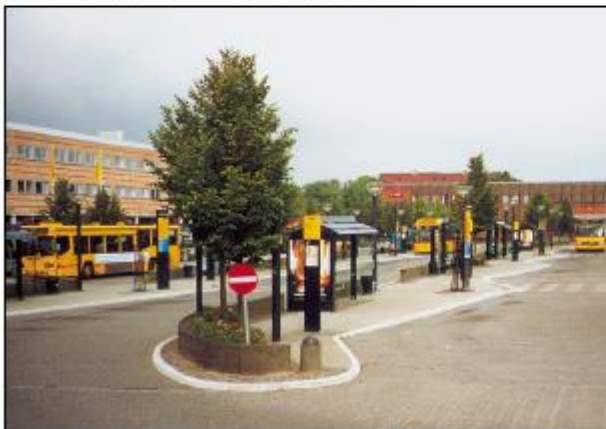
Busterminalen foran Ballerup station har 16 buspladser med savtandsopstilling
