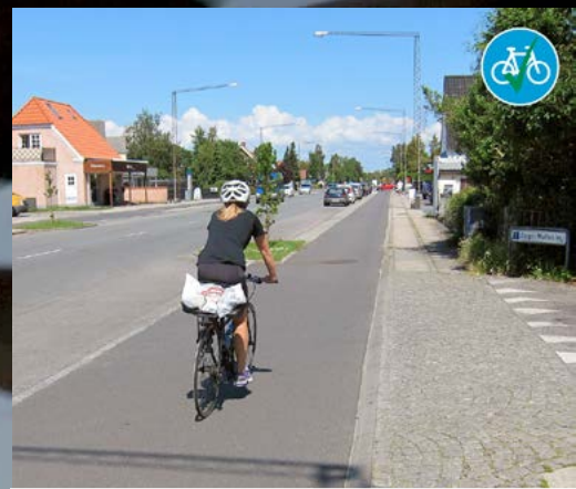
Her er en cykelsti der er ført ubrudt gennem en overkørsel. Udover at sikre god fremkommelighed for cyklister skaber løsningen klare vigepligtsforhold i krydset.
